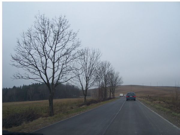
ODCINEK WYREMONTOWANEJ DROGI POWIATOWEJ STARA BIRCZA-WARA
